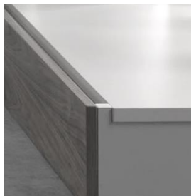
rys.1- Wcięcie w ścianie bocznej, dystans między frontem a wieńcem górnym
